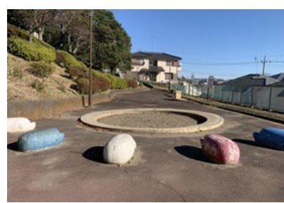
写真3 遊具の老朽化
